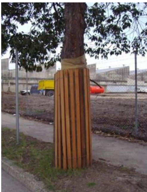
Rysunek 9 Przykład prawidłowego odeskowania drzewa podczas prac budowlanych
